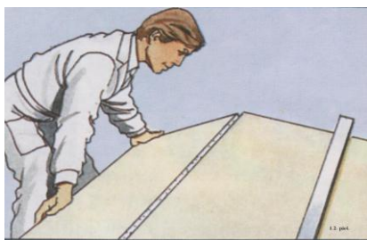
60 pav. Gipso kartono plokštės laužimas
