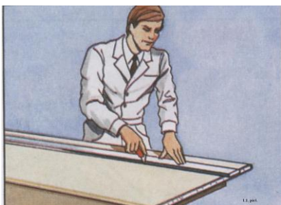
59 pav. Gipso kartono plokštės pjovimas iš gerosios pusės
