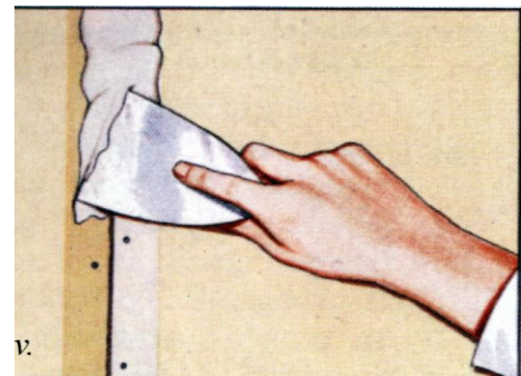
65 pav. Siūlės užglaistymas
